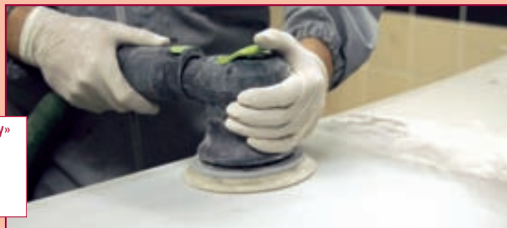
11. Начинают шлифовку грунта вручную абразивным материалом P320, предварительно нанеся на поверхность проявочное покрытие.
