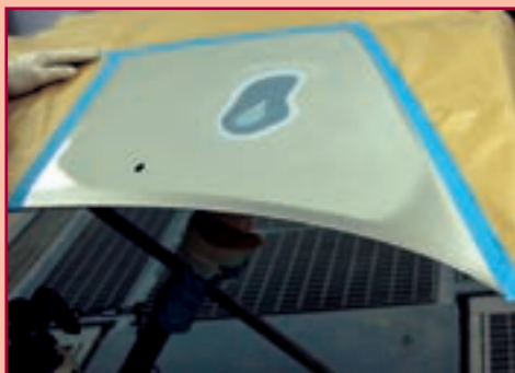
6. Маскировать деталь приходится с «запасом», иначе «ступенька», образовавшаяся на границе грунта, может проявиться на готовом покрытии. При отсутствии достаточного опыта маляру следует использовать валик вместо малярной ленты.
